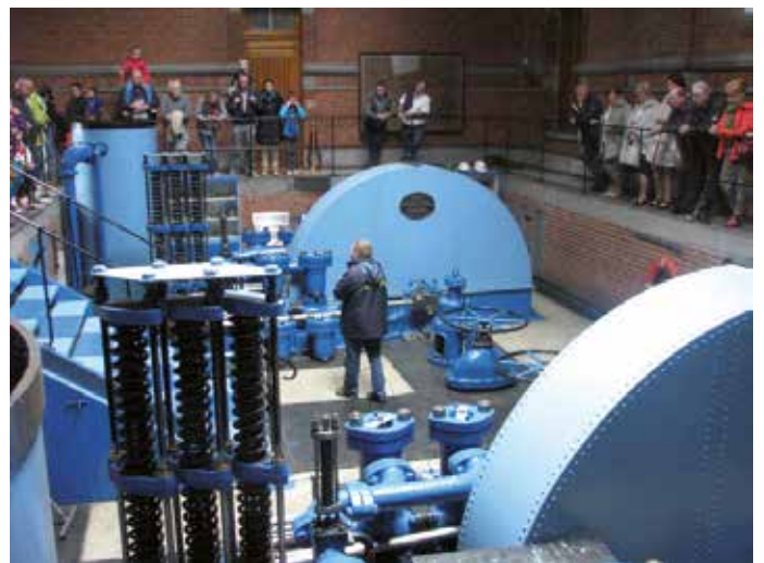
Salle des machines
